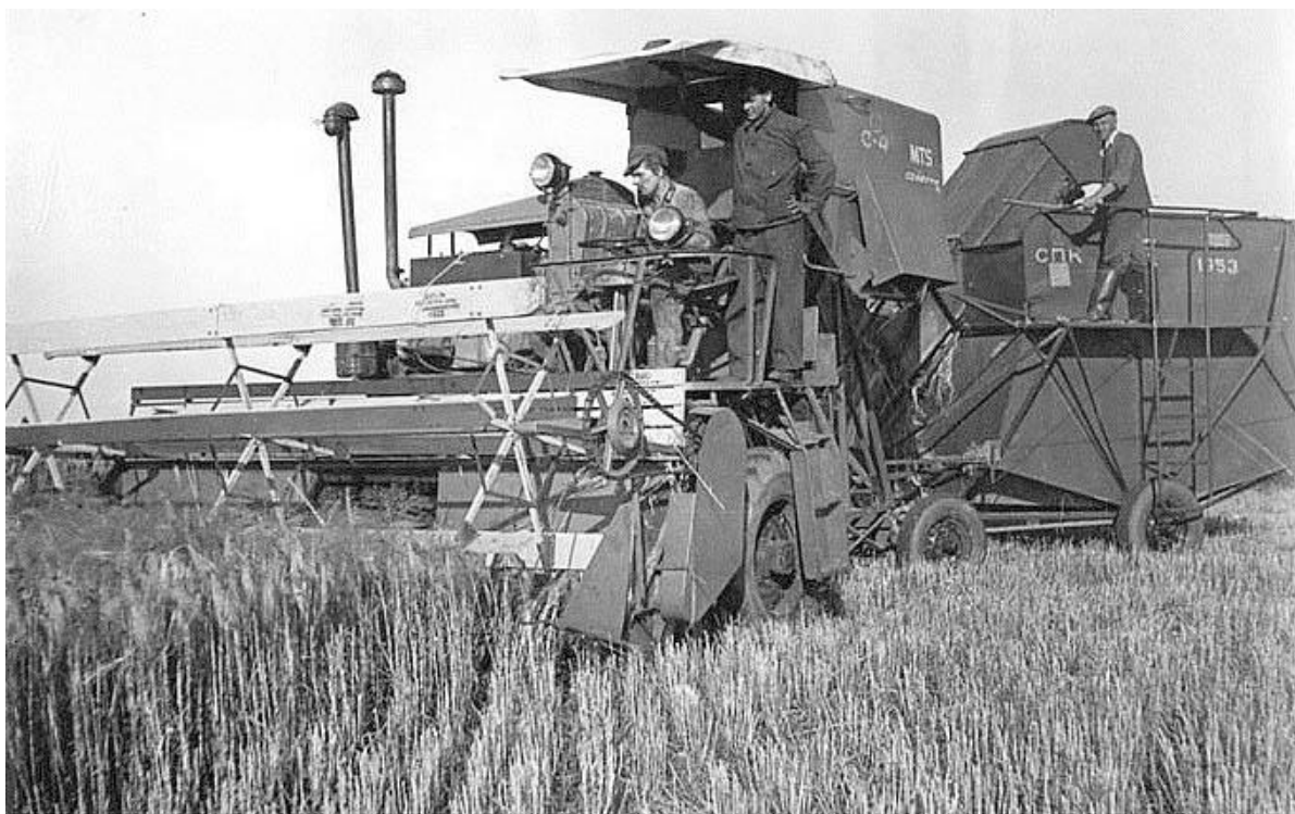
Комбайн «ЖМС-4» (жатка-молотилка самоходная), которое в производстве было сокращено до «С-4».
