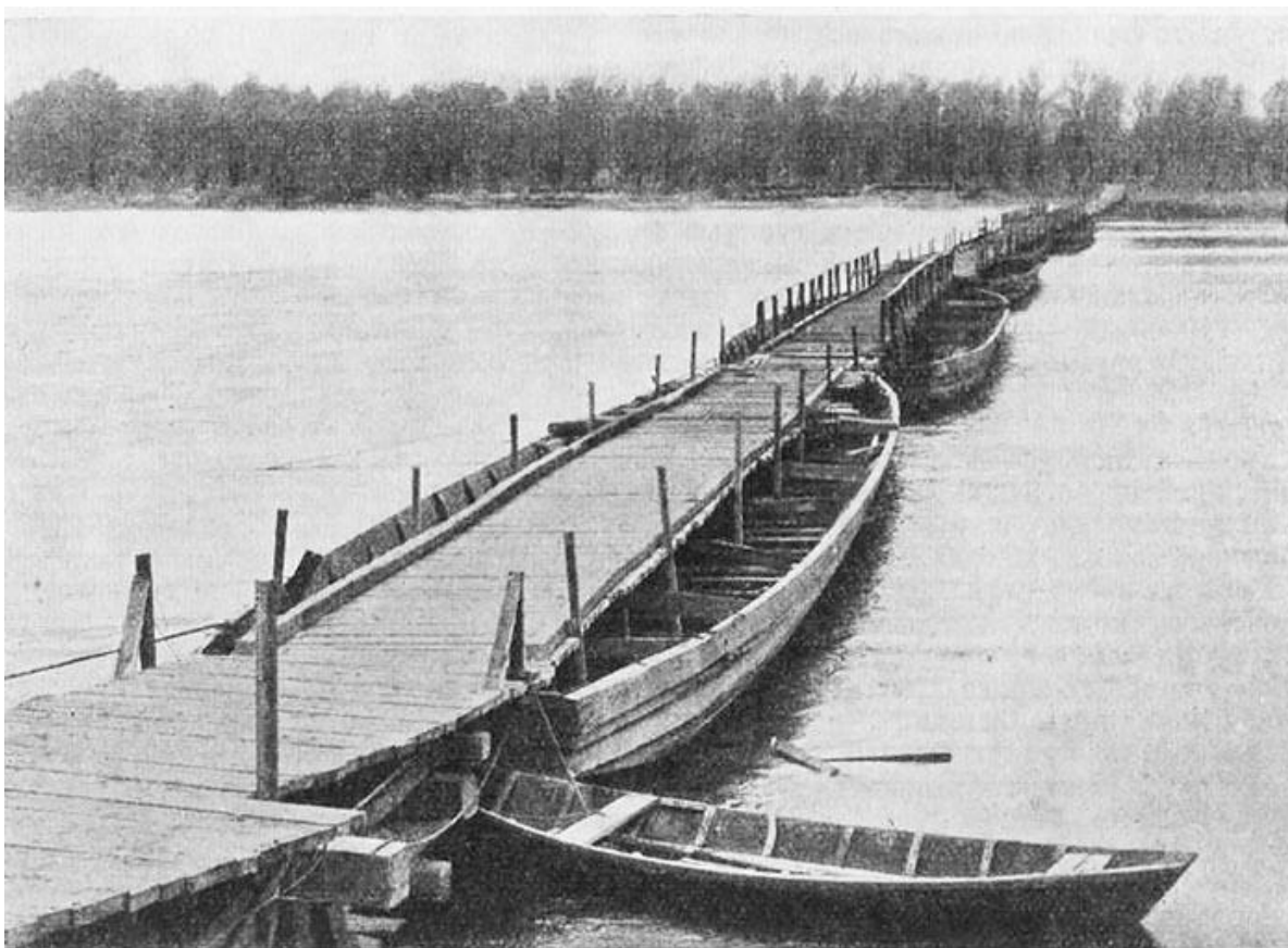
Моторно-понтонный парк Неговского. Понтонный мост через Вислу. Нива. 1914. № 50. Источник - https://topwar.ru/130370-armeyskoe-forsirovanie-chast-3.html
