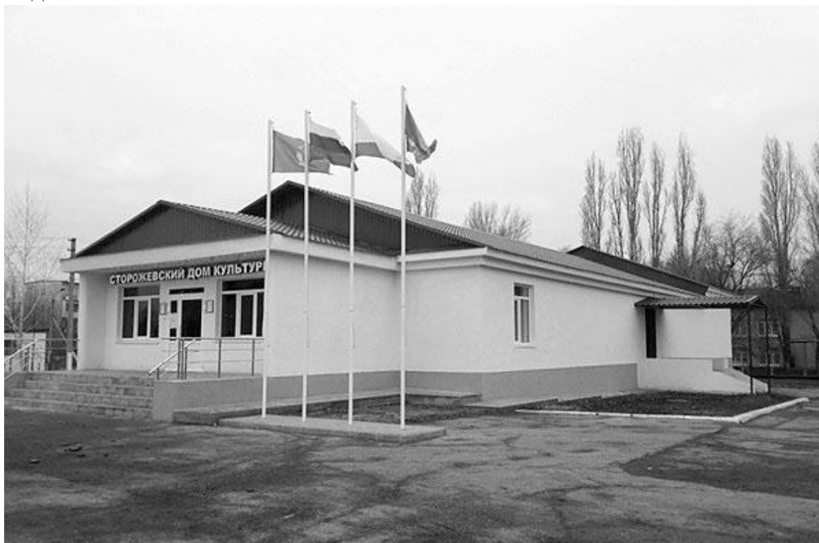
Сторожевский Дом Культуры после ремонта.
