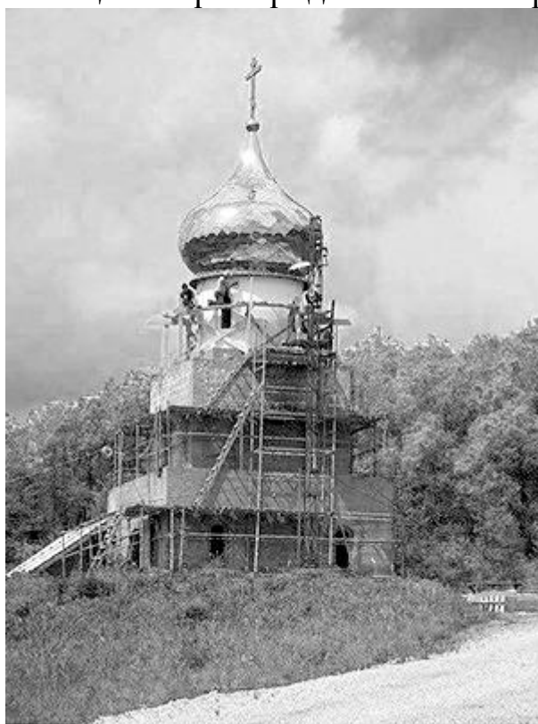
2007 год — строительство старообрядческого Поморского храма
