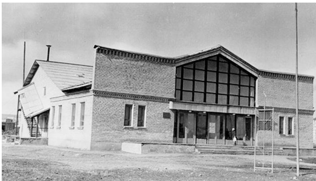
Административное здание колхоза им. Ленина в с. Идолга и клуб с. Широкое, построенные МПМК.
